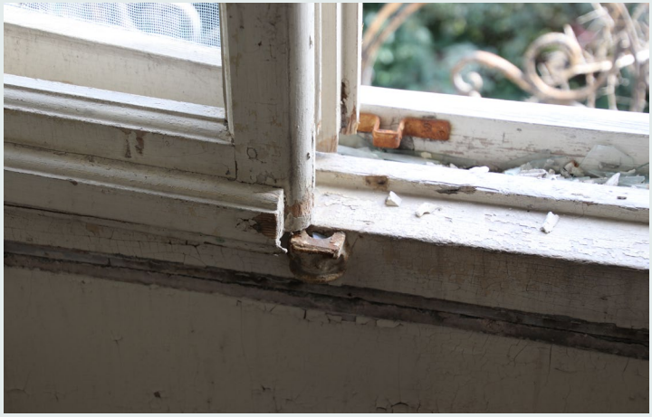
2 Dettaglio sistema di chiusura di un infisso in legno con vetro singolo
