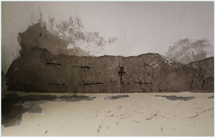
1 Solaio in cemento armato a piastra piena
